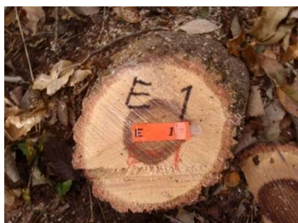
木口断面の調査
