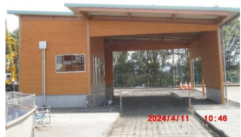
完成した選別機建屋
